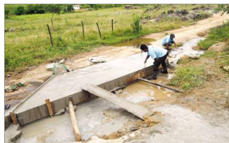
A parceria entre Prefeitura e comunidade está possibilitando a construção de uma ponte sobre o Córrego São Bento
